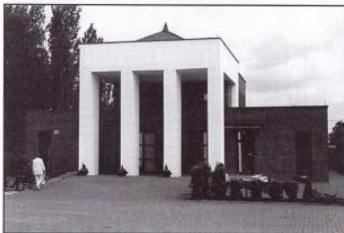
Front funerarium, z wejściami do kaplicy i pomieszczeń recepcyjnych.
